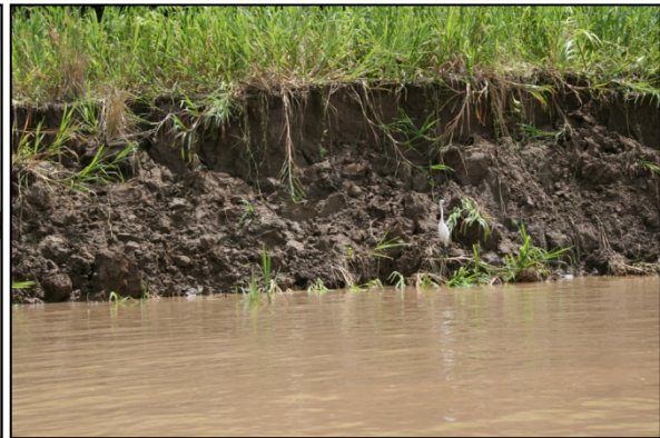
Faible hauteur de la berge
