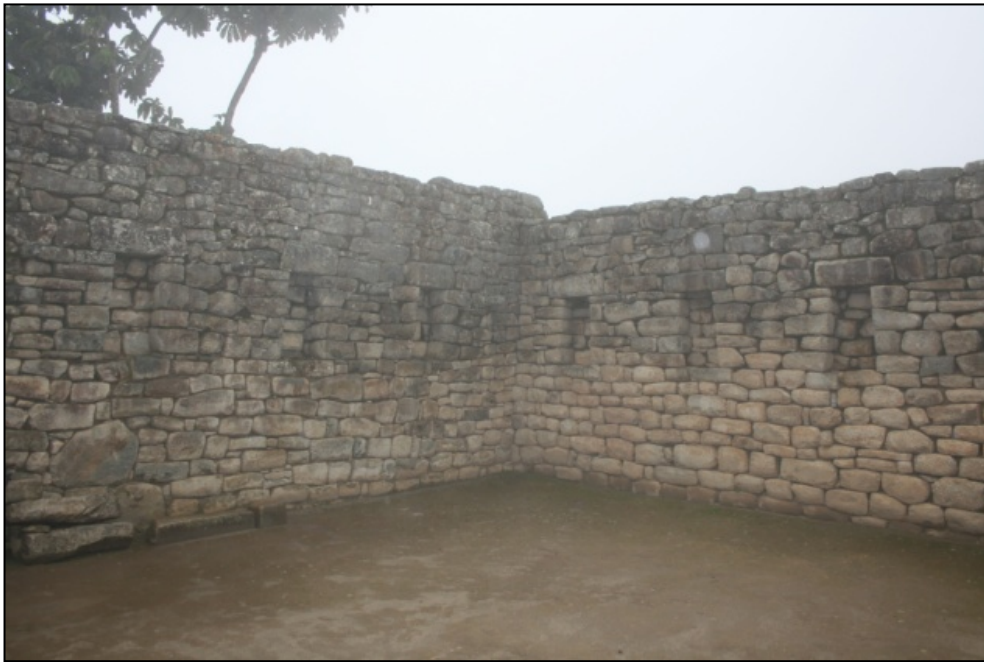
Maison du Grand Prêtre
